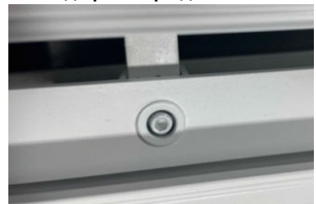
Узел регулировки подвижного дефлектора для Рег 1
